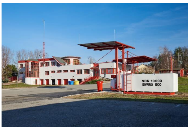
Nádrž na naftu včetně výdeje – středisko UH
