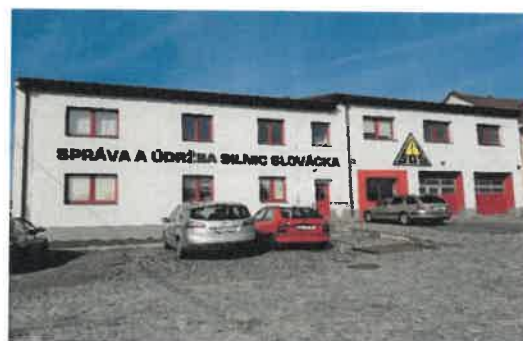
Zateplení střediska Uh. Brod
