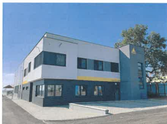
Administrativní budova a dílny Uh. Brod
